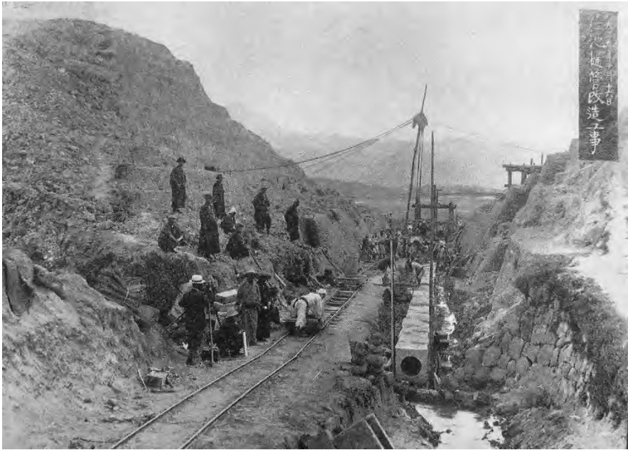
写真 4:仁池(にいけ)の閘替工事 (香川県丸亀市飯山町上法軍寺 慶安二年(一六四九)築造) 大正九年に木製の閘を直径一尺五寸長さ四二間の石閘に伏替えられた
